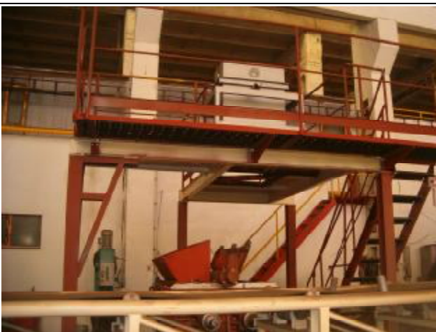
Foto 7 – Structura de rezistentă – etaj malaxor
